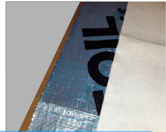
3. V prípade použitia separačnej geotextílie ako mikroventilačnej vrstvy pod mPVC fóliou sa geotetília na vodorovnej ploche atiky skráti o 50mm, tak aby bol viditeľný okraj vrstvy CONTROFOIL pre uloženie oplechovania a vytvorenie elektricky vodivého kontaktu.
