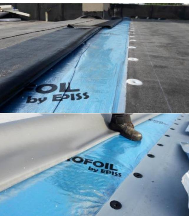
2. Ukladá sa priamo na tepelnú izoláciu a tvorí vodivý podklad pod povlakovú krytinu z mPVC, TPO fólie alebo pod mechanicky kotveným modifikovaným asfaltovaným pásom
